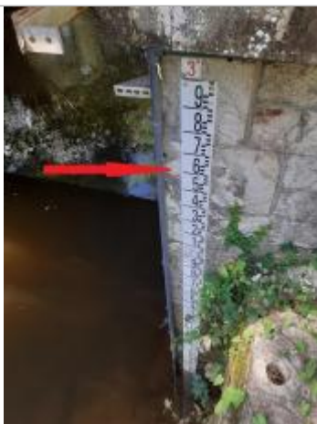
Echelle limnimétrique en aval du pont
