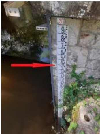
Echelle limnimétrique en aval du pont
