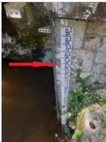
Echelle limnimétrique en aval du pont
