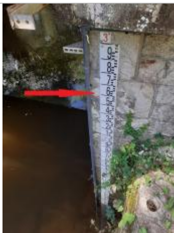
Echelle limnimétrique en aval du pont
