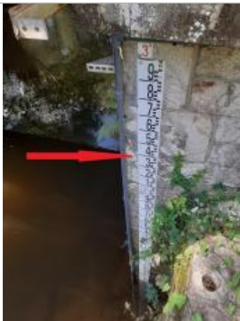
Echelle limnimétrique en aval du pont
