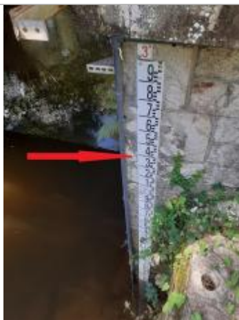
Echelle limnimétrique en aval du pont
