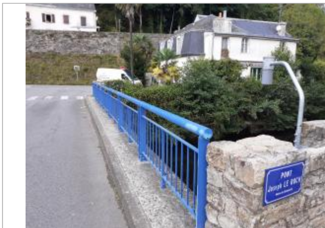
station des anciennes fonderies, pont Joseph Le Roch
