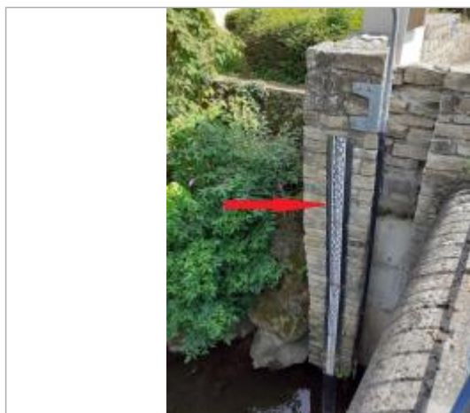
Echelle limnimétrique en amont du pont
