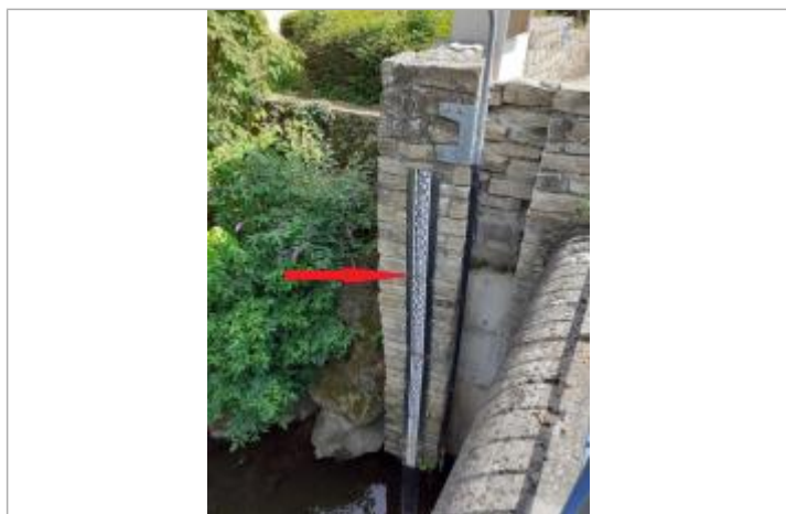
Echelle limnimétrique en amont du pont
