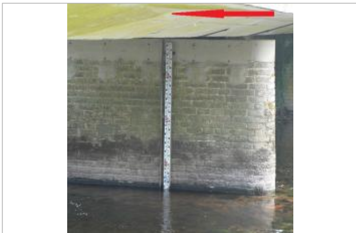
Echelle limnimétrique sous le pont
