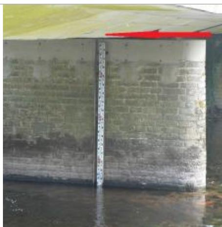
Echelle limnimétrique sous le pont
