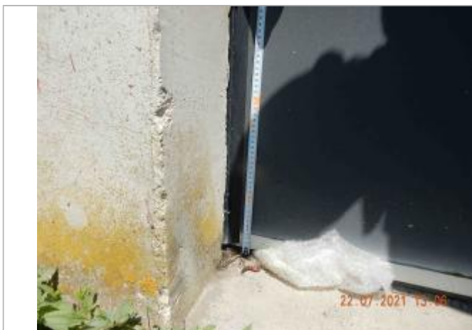
Laisse de crue (sédiments) sur la porte du garage à 17 cm/sol
