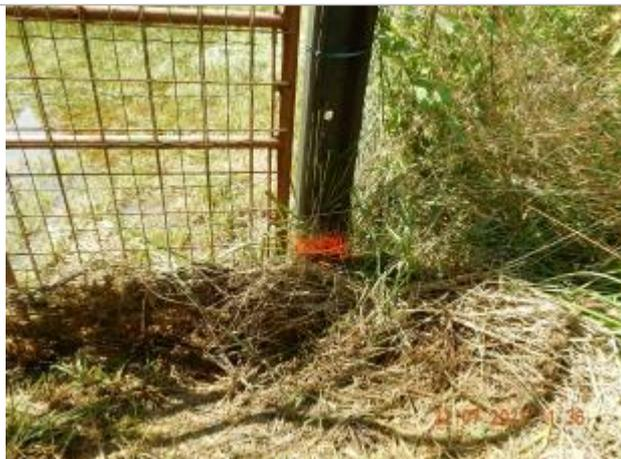
Laisse de crue sur pilier en ciment du portail métallique à 28 cm/sol
