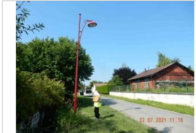
Lampadaire rouge "Useda n°106" rue de Dorigny face à un hangar rouge
