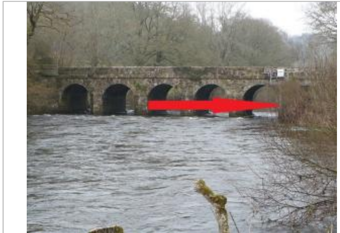
Pont de Ty-Nadan vue de l'aval
