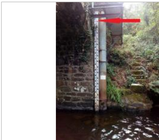
Echelle limnimétrique en aval du pont
