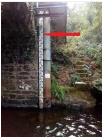
Echelle limnimétrique en aval du pont
