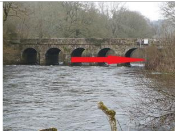
Pont de Ty-Nadan vue de l'aval
