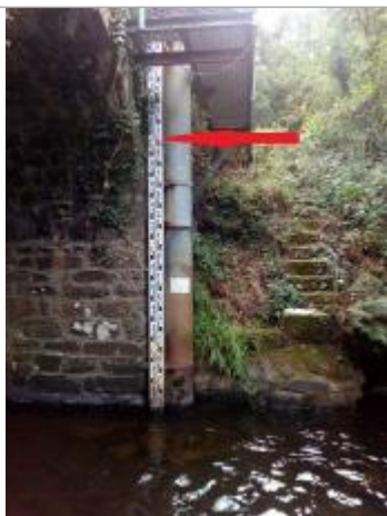
Echelle limnimétrique en aval du pont
