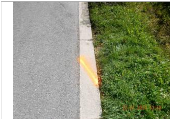
Laisse de crue sur la chaussée
