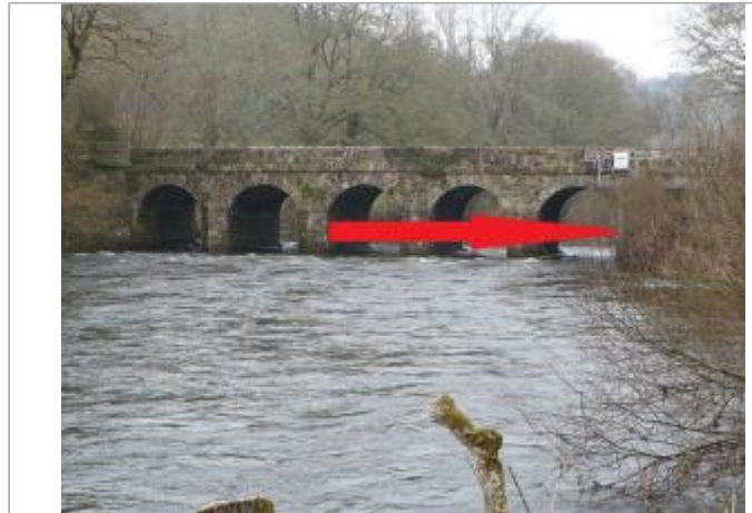
Pont de Ty-Nadan vue de l'aval
