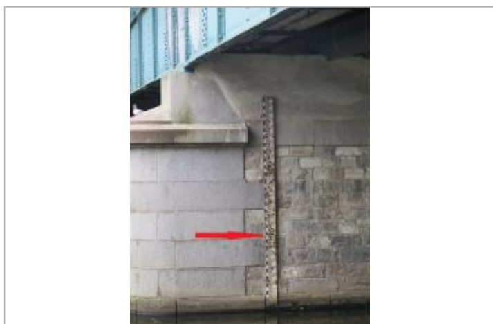
Echelle limnimétrique en amont sur la pile centrale du pont
