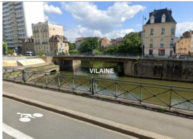
Pont Richemond vue de l'amont, du quai Dujardin
