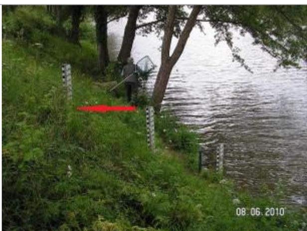
Echelles limnimétriques en 2010 - niveau de la crue de 1977
