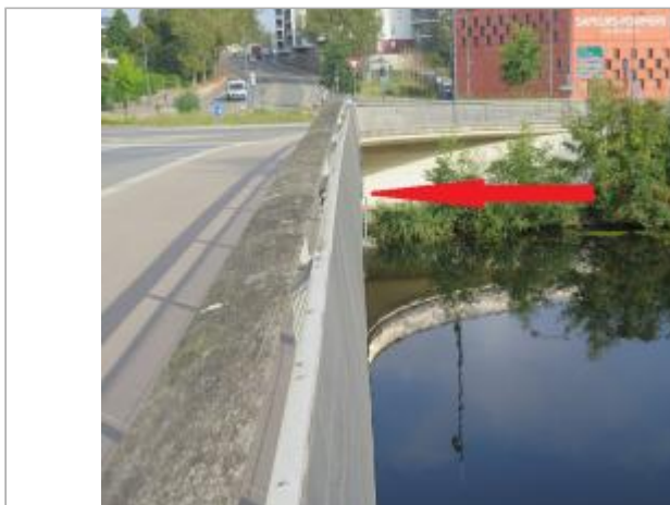
Vue du dessus du pont vaclav Havel
