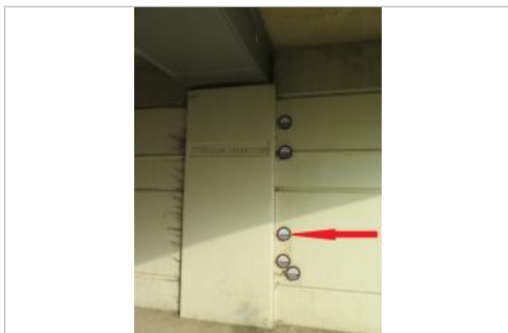
vue des repères du passage piéton sous le pont
