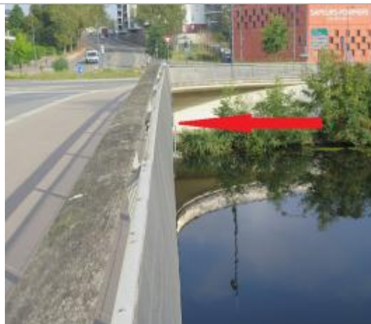
Vue du dessus du pont vaclav Havel
