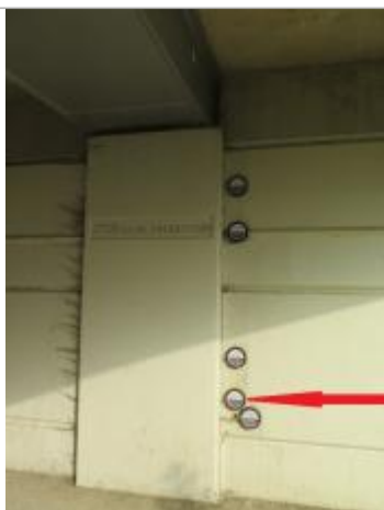
vue des repères du passage piéton sous le pont
