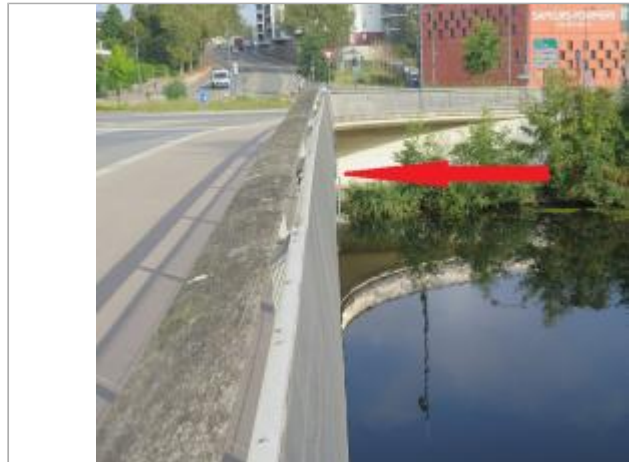
Vue du dessus du pont vaclav Havel
