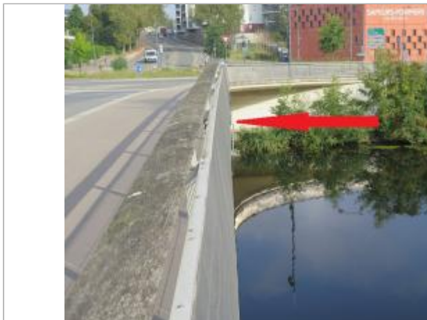
Vue du dessus du pont vaclav Havel
