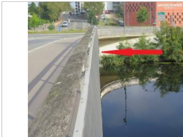
Vue du dessus du pont vaclav Havel
