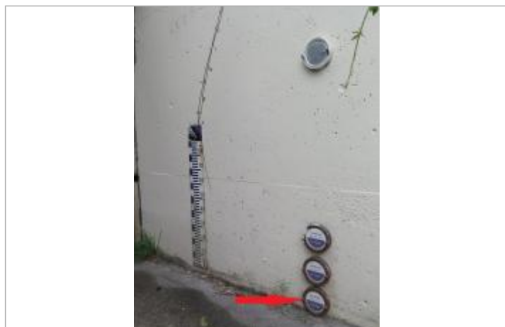
vue des repères du passage piéton
