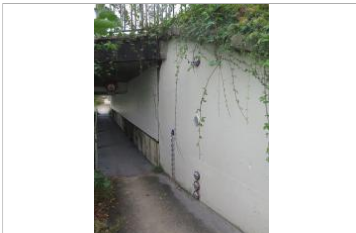
Vue générale du passage piéton à l'amont du pont
