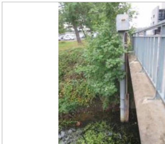
Ancienne station (échelle limnimétrique disparue) à l'amont du pont du chemin de Baud
