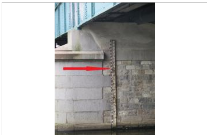
Echelle limnimétrique en amont sur la pile centrale du pont
