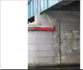
Echelle limnimétrique en amont sur la pile centrale du pont
