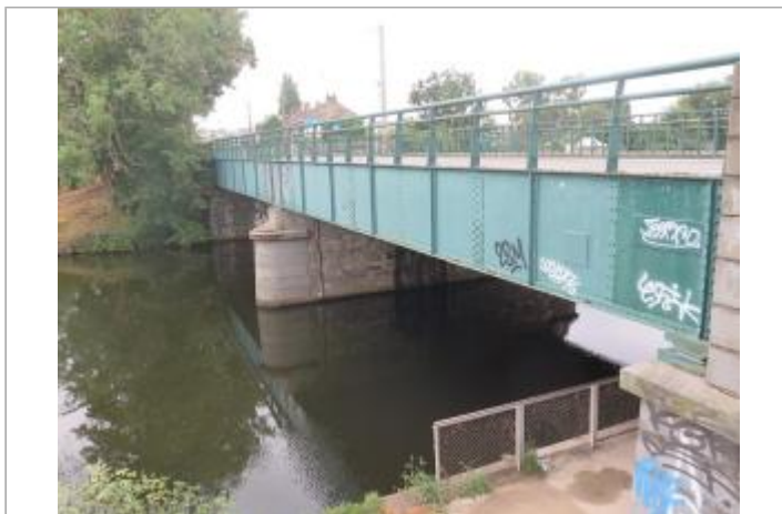
Vue générale à l'amont du clapet dit du pont Villebois Mareuil
