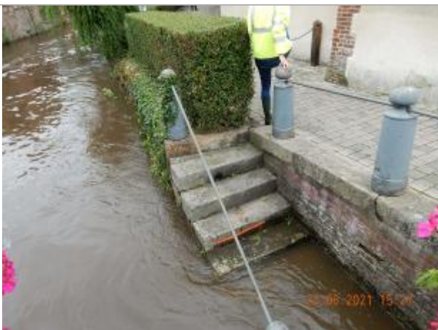
Marque de peinture sur la marche en pierre de l'escalier
