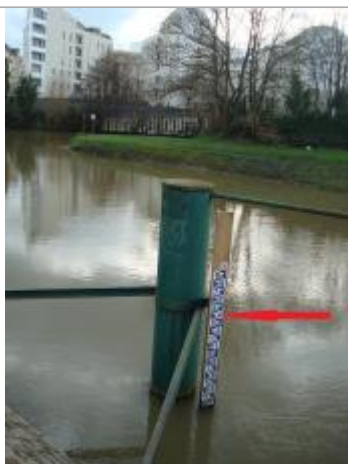
Echelle limnimétrique en amont du clapet dit du cabinet vert à Rennes
