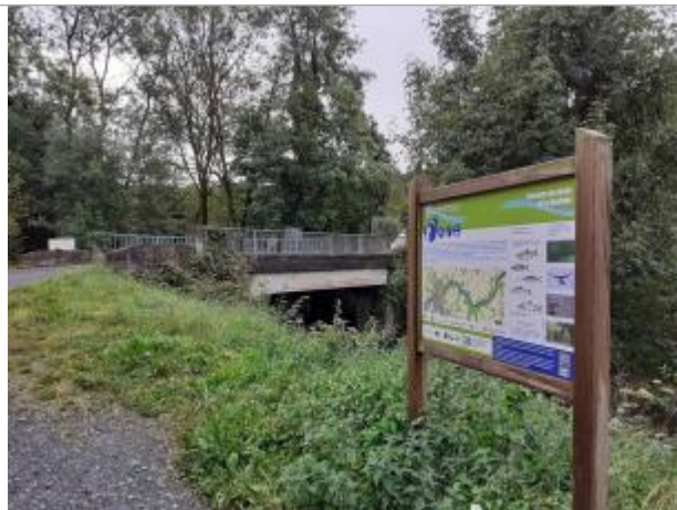
vue générale du site de la station hydrométrique de la Douffine
