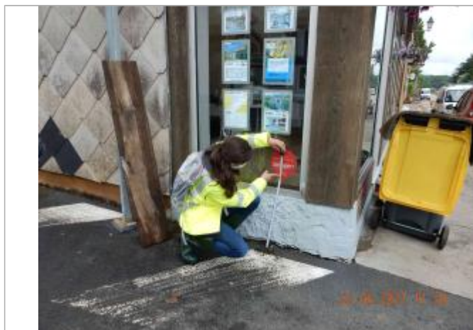
Laisse de crue sur vitrine de l'agence immobilière à 54 cm/sol
