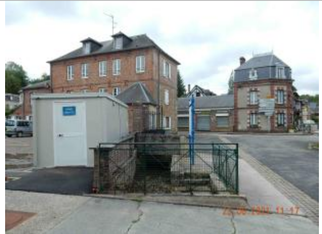
Rambarde metalique sur pont situé entre le 19 et le 17 rue Grande
