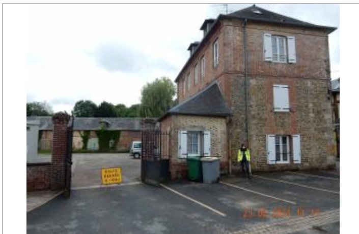
19 rue Grande, Portail de la cour du local technique de la commune
