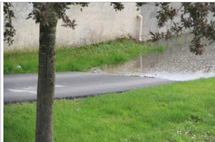
Chemin de halage au niveau du Pont Major KC Crummer (en aval)
