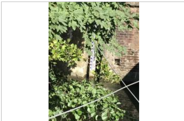
Route de Poses au niveau du Pont Jules Bourdot, échelle limnimétrique
