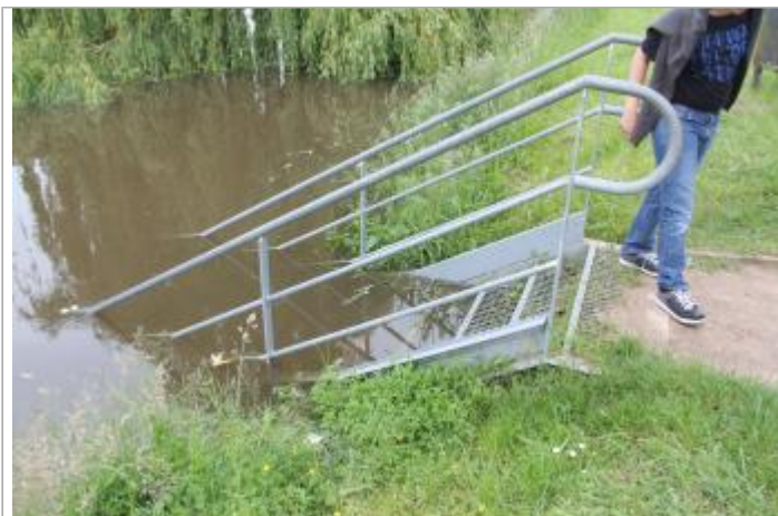
Vue du site lors de la crue
