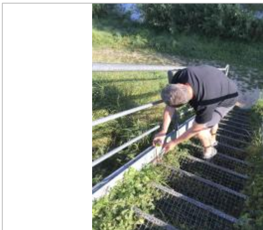
Laisse de crue à 4 cm/dessus de la 4ème marche
