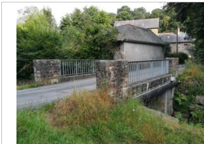
Station hydrométrique de l'IC à Binic
