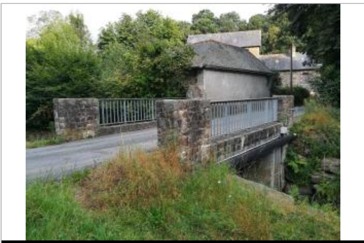
Station hydrométrique de l'IC à Binic
