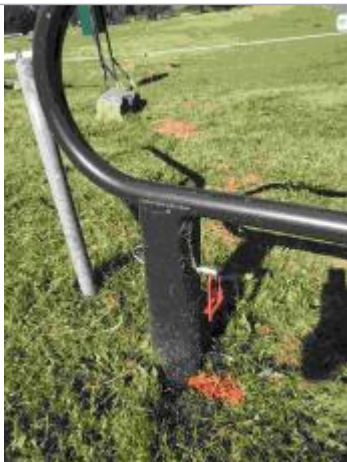
Laisse de crue au sol sur piste cyclable
