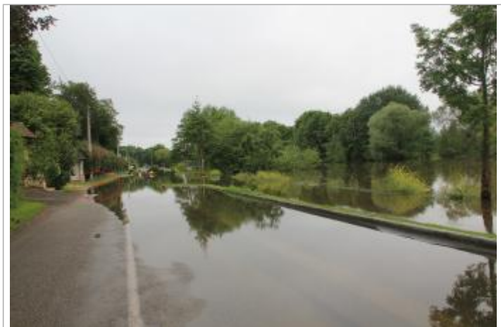
Laisse de crue au sol recouvre l'intégralité de la chaussée
