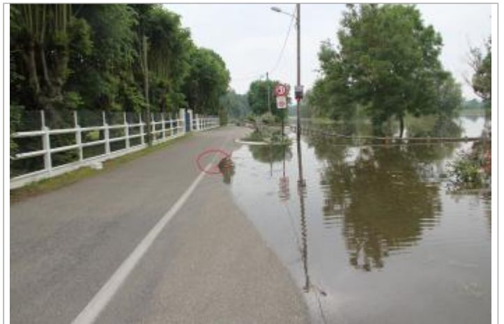
Route de l'Eure à proximité immédiate du n°46
