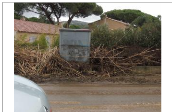
Vue du repère - Photo © CCGST
