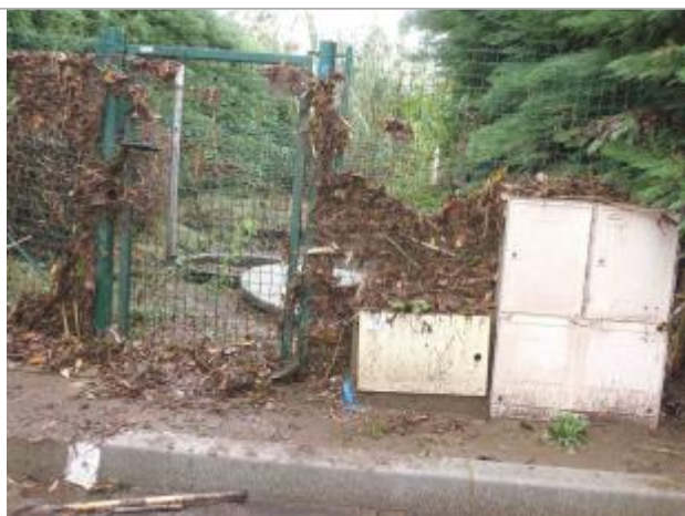
Vue du repère - Photo © CCGST
