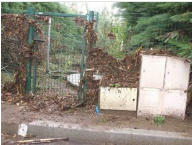
Vue du repère - Photo © CCGST
