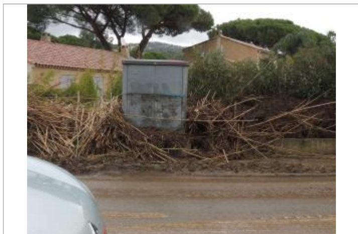
Vue du repère - Photo © CCGST
