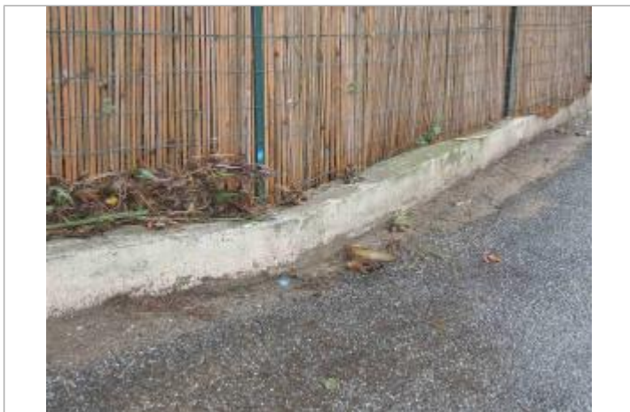
Vue du repère - Photo © CCGST
