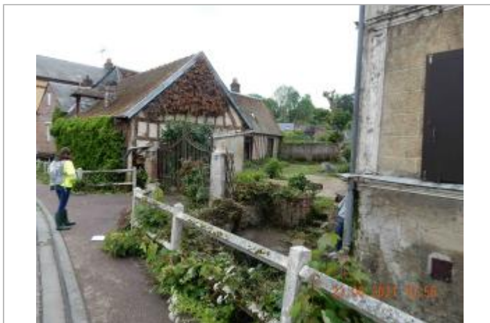
1 rue du Moulin ouvrage à clapet
