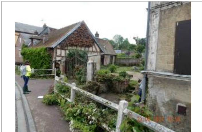
1 rue du Moulin ouvrage à clapet
