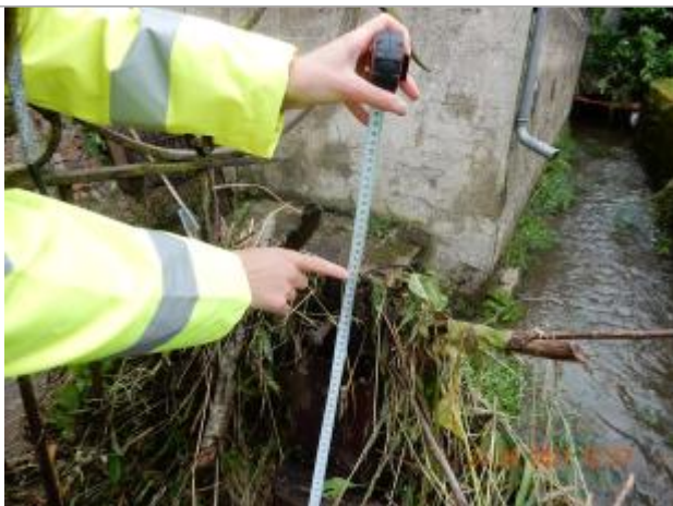
Laisse de crue à 65 cm de la margelle en brique
