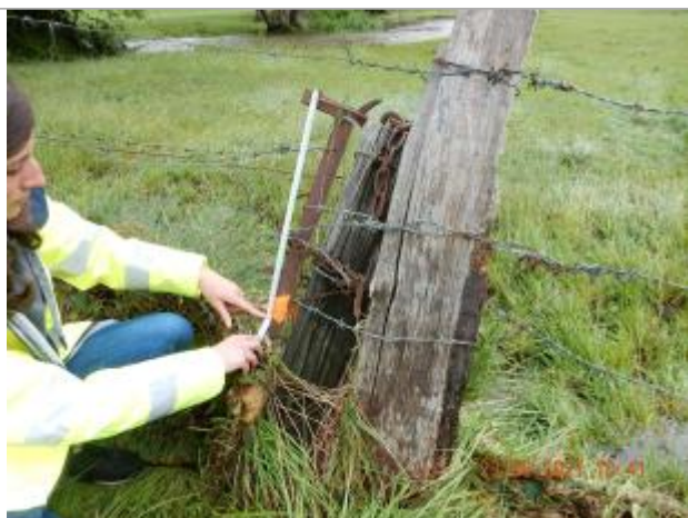
Laisse de débris de végétaux sue le grillage
