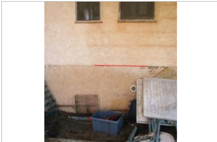
Vue du site - photo DDTM83
