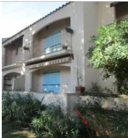
Vue du site - photo DDTM83
