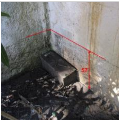
Vue du repère - photo DDTM83
