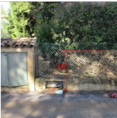
Vue du repère - photo DDTM83
